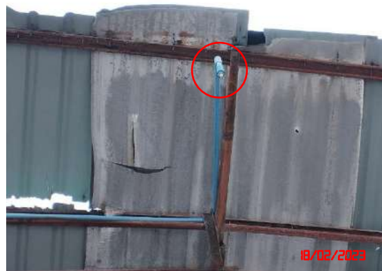
ระบบสเปรย์น้ำบริเวณแหล่งกำเนิดฝุ่นละออง
